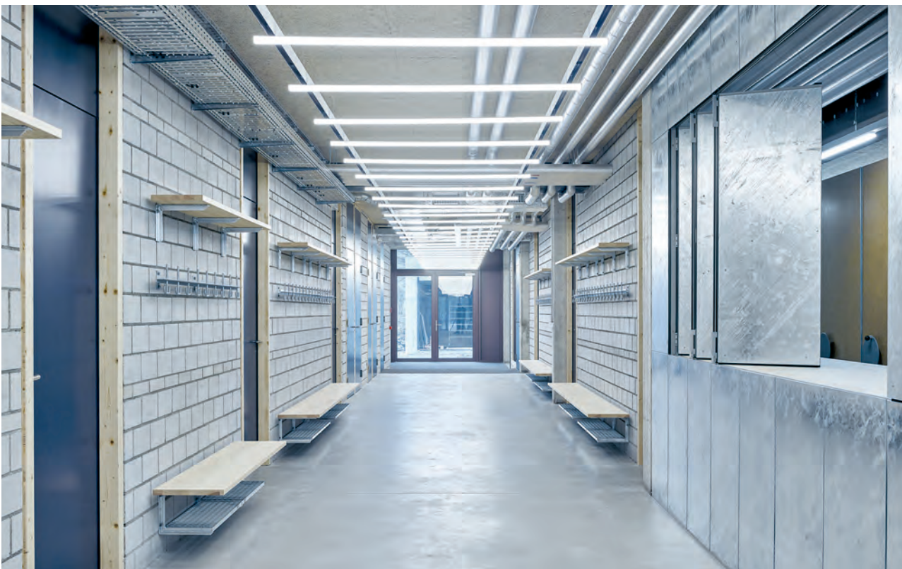
Korridor im Untergeschoss mit Garderobe und Materialausgabe
