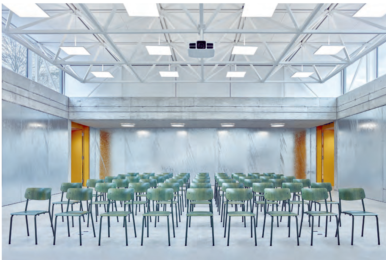
Der vergrösserte Theoriesaal mit dem charakteristischen Raumfachwerk und zwei seitlichen Oblichtern im Obergeschoss.
