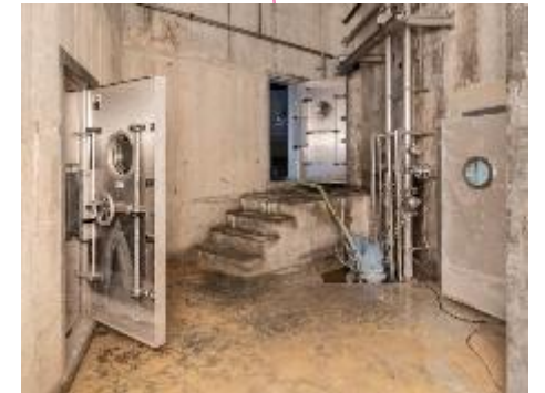
St. Gallen: Unterirdisches Retentionsbecken
