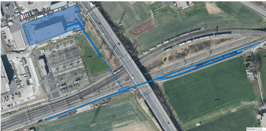
Abbildung 16: Bestehende Entladeanlage der «Bahnkies Rotkreuz»
