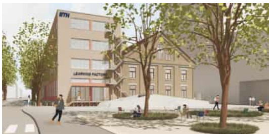
Abbildung 10: Ansicht des Gebäudes
