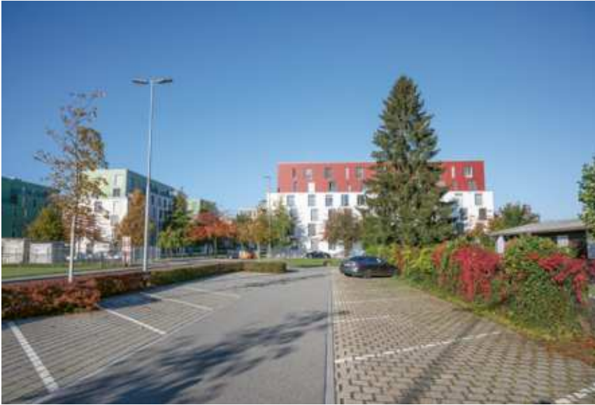
Parkplätze im Bereich der Allmendstrasse. (Bild VDW)
