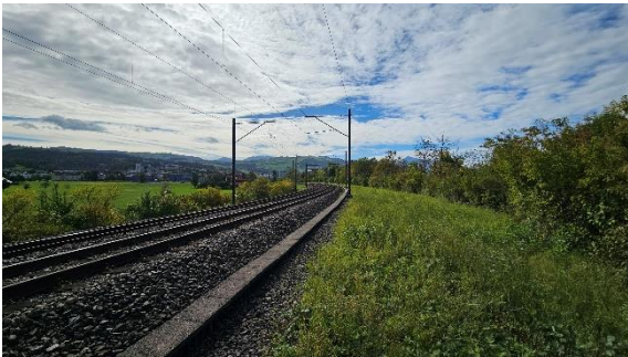
Abbildung 7 und 8: über den Boden ragende Kabelkanäle (ca. Km 25.535 Blickrichtung Süd)
