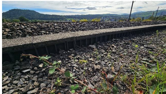
Abbildung 7 und 8: über den Boden ragende Kabelkanäle (ca. Km 25.535 Blickrichtung Süd)
