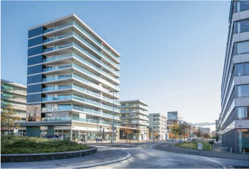
Kreuzung Nord- und Feldstrasse. (Bild VDW)
