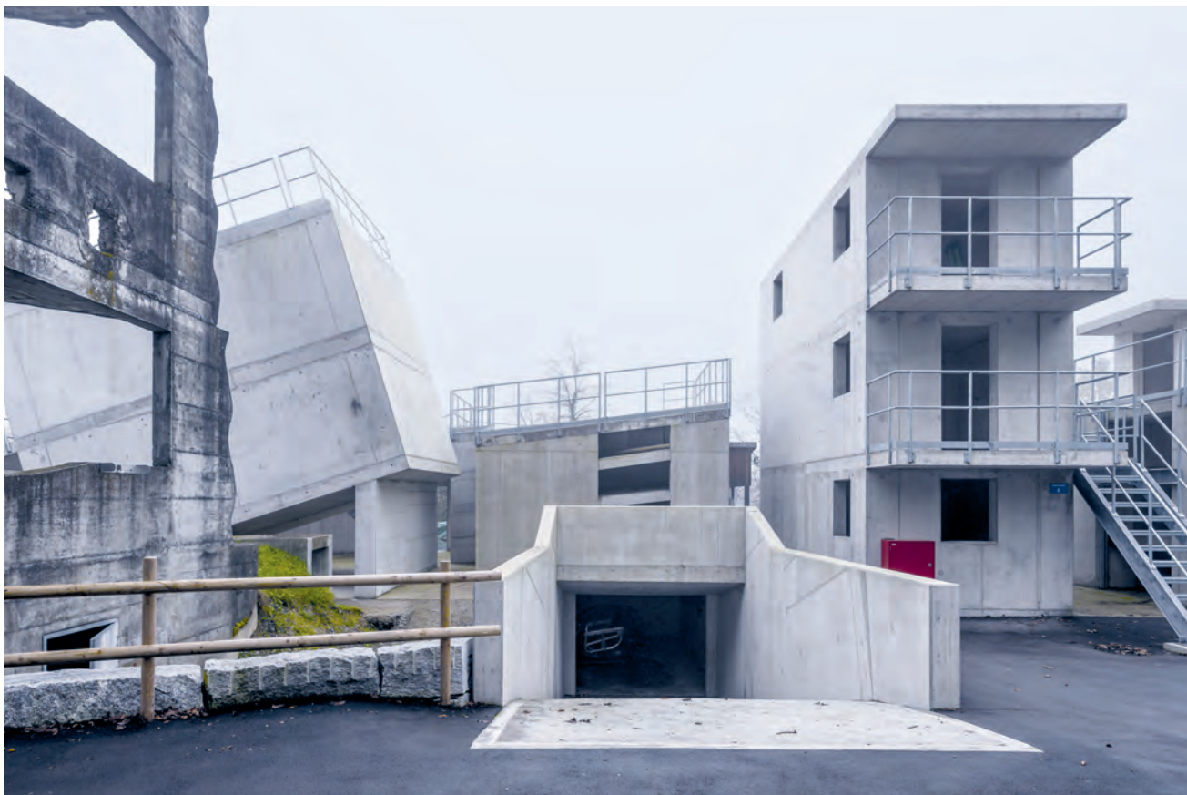
Ansicht von Osten mit Rampe ins Untergeschoss
