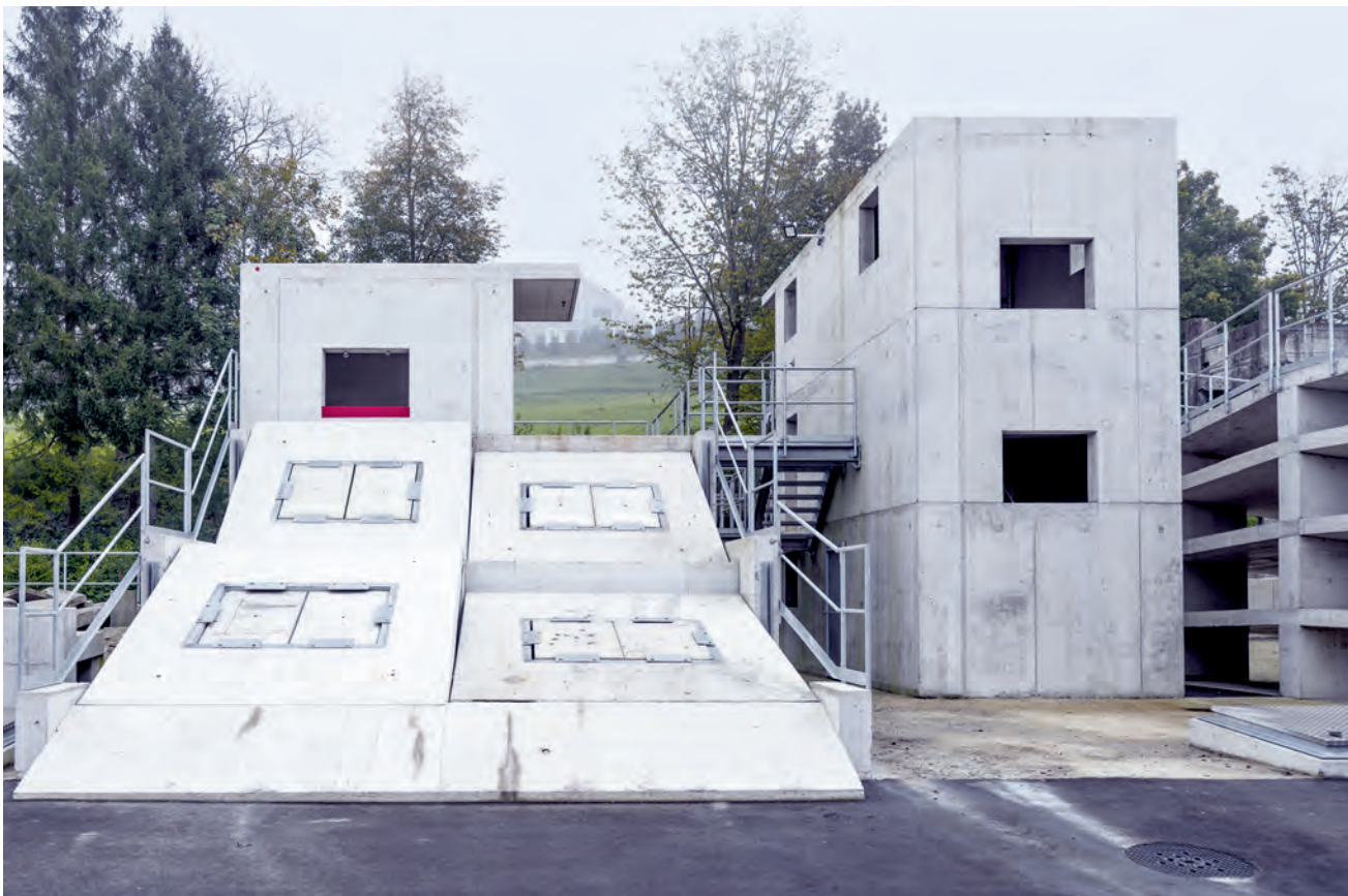
Ansicht von Westen mit beweglichen Trümmerplatten
