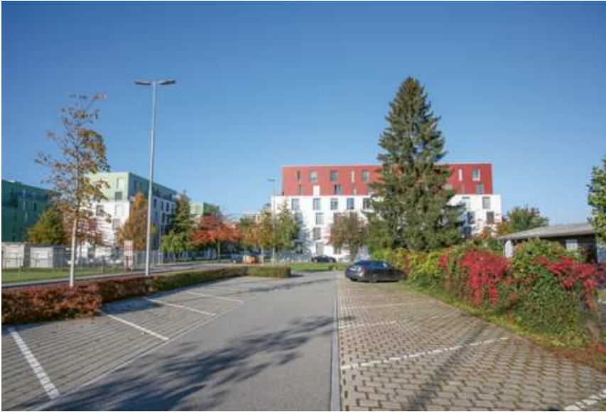
Parkplätze im Bereich der Allmendstrasse. (Bild VDW)
