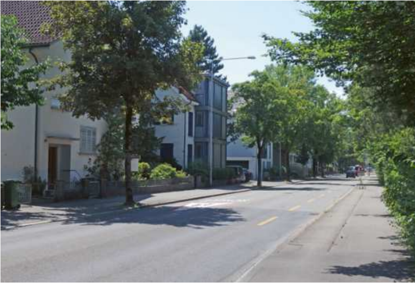
Industriestrasse: Quartierstrasse, übergeordnet, Lage in der Ebene. (Bild VDW)
