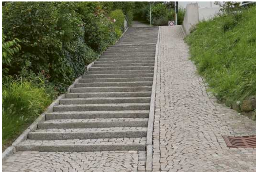
Bohgutsch/Ägerisaumweg: Treppe mit Rampe als wichtige Verbindung am Hang. (Bild SZG)
