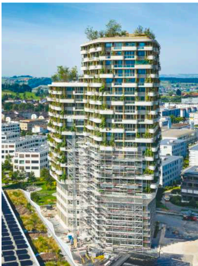
4 Gartenhochhaus «Aglaya», Suurstoffi, Rotkreuz
