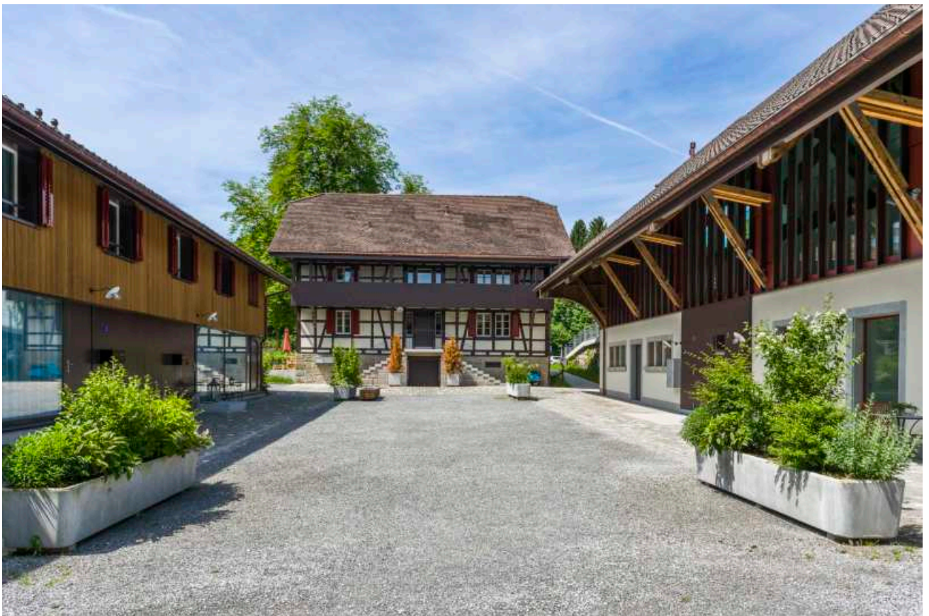
2 Wohnüberbauung Hammergut, Cham
