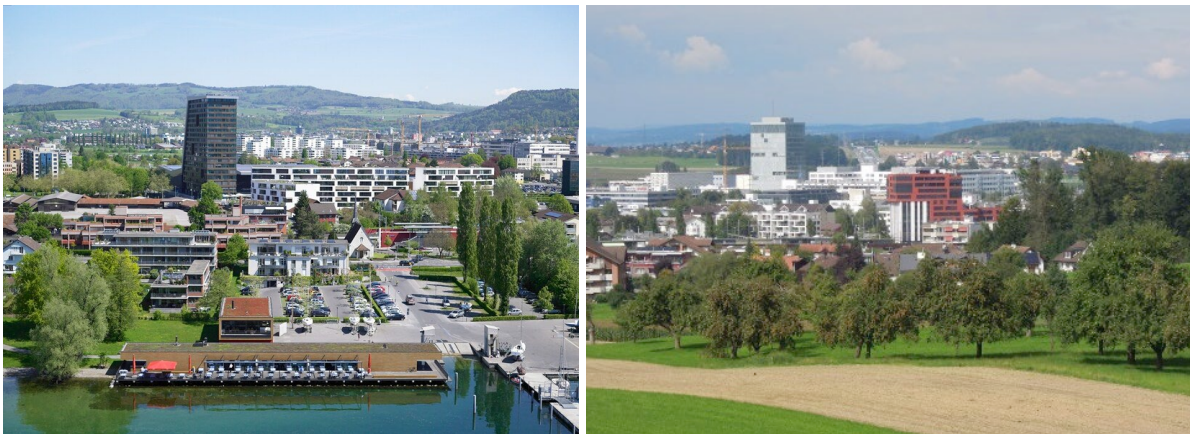
Siedlungslandschaft Zug mit Bebauung aus verschiedenen Epochen und Rotkreuz mit schön strukturiertem Siedlungsrand. (Foto links: Flying Camera / Foto rechts: ARV)
