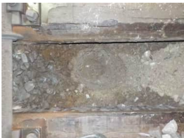
Bild 81: Gleis 91, km 25.400: Blick in den Aufschluss, der Unterbau besteht aus leicht siltigem Kies mit Sand und einzelnen Steinen (Bodengruppe GP-GM)
