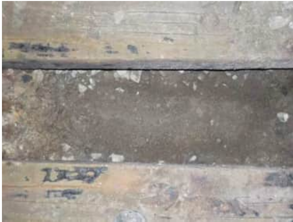
Bild 49: Gleis 92, km 24.900 : Blick auf die Planie
