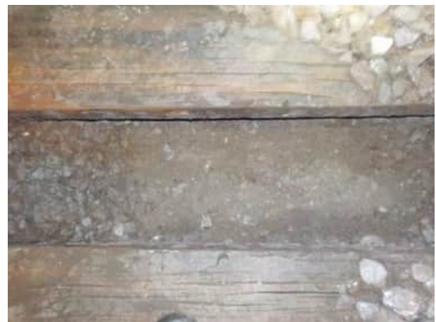
Bild 76: Gleis 92, km 25.290 : Blick auf die Planie
