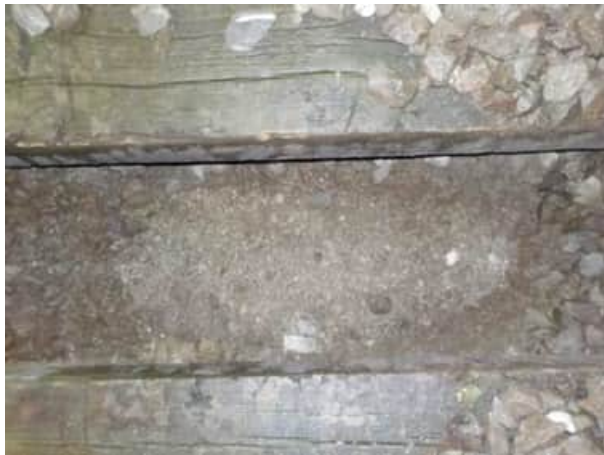
Bild 61: Gleis 91, km 25.055 : Blick auf die Planie
