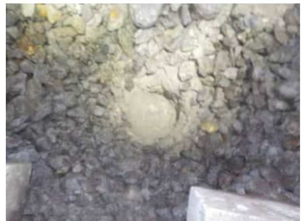
Bild 14: W 1, km 23.725 (Bereich seitliche Schiebung): Blick in den Aufschluss, der Unterbau besteht aus (leicht) siltigem Kies mit viel Sand (Bodengruppe GM), darunter ist ein Geotextil (Vlies) verlegt
