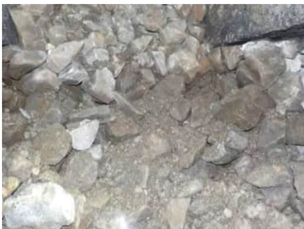
Bild 59: Gleis 91, km 24.970: Schotter in den Schienenbereichen allenfalls mittelmäßig (S2) verschmutzt, wirksam stopf- und reinigbar
