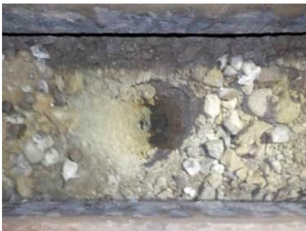
Bild 75: Gleis 91, km 25.300 : Blick in den Aufschluss, der Unterbau besteht aus sauberem Kies mit Sand und einzelnen Steinen (Bodengruppe GP)
