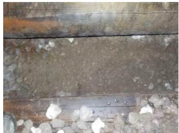
Bild 70: Gleis 92, km 25.170: Blick auf die Planie
