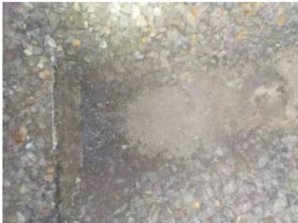
Bild 19: W 1, km 23.725 (Bereich seitliche Schiebung): Blick auf den Schlitz im Randbereich zwischen Schwellenkopf und Kabelkanal
