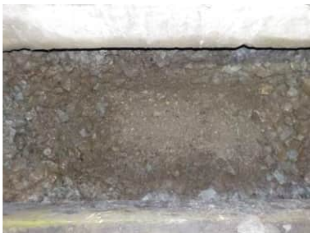
Bild 23: Gleis 21-425, km 23.815: Blick auf die Planie
