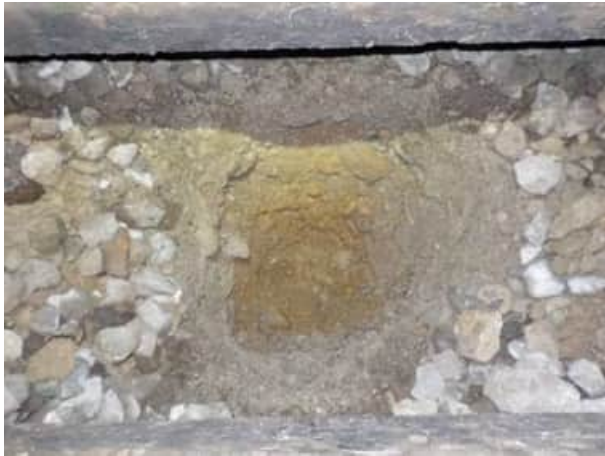
Bild 55: Gleis 92, km 24.970: Blick in den Aufschluss, der Unterbau besteht aus leicht siltigem Kies mit Sand und Schotter/Steinen (Bodengruppe GP-GM)
