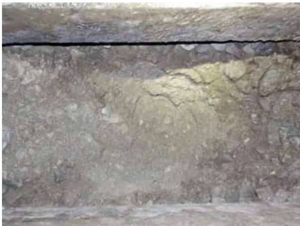
Bild 99: Gleis 425, km 25.890: Blick in den Aufschluss, der Unterbau besteht aus leicht siltigem Kies mit (viel) Sand und einzelnen Steinen (Bodengruppe GP-GM)
