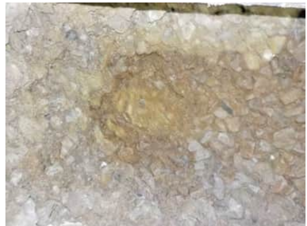
Bild 28: Gleis 21-425, km 23.920: Blick in den Aufschluss, das Schotterbett reicht bis in eine Tiefe von 1 m unter SwOK, dann folgt leicht siltiger Kies/Schotter mit Sand (Bodengruppe GP-GM)
