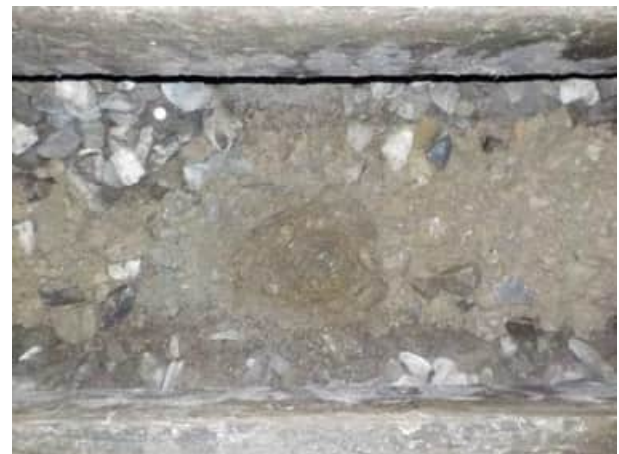
Bild 102: Gleis 325, km 25.890: Blick in den Aufschluss, der Unterbau besteht aus leicht siltigem Kies mit Sand und einzelnen Steinen (Bodengruppe GP-GM)
