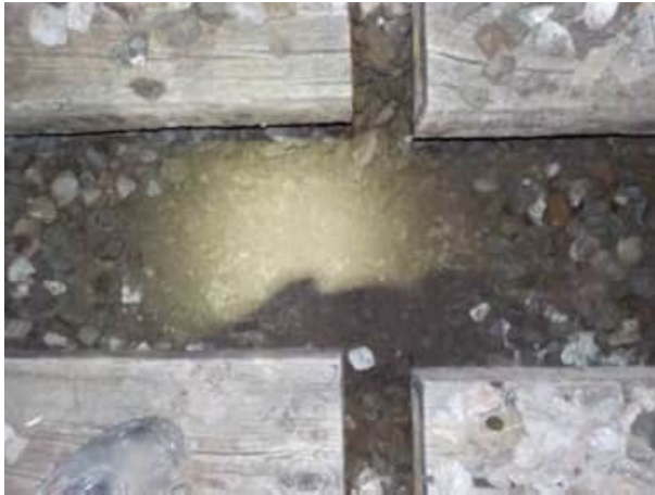
Bild 43: W8/9, km 24.815, Ablenkung: Blick auf die Planie
