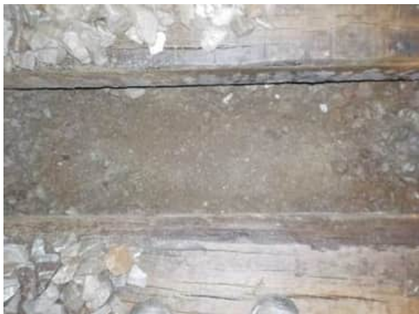
Bild 79: Gleis 91, km 25.400: Blick auf die Planie
