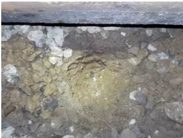
Bild 51: Gleis 92, km 24.900 : Blick in den Aufschluss, der Unterbau besteht aus leicht siltigem Kies mit Sand und Schotter/Steinen (Bodengruppe GP-GM)
