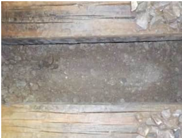
Bild 73: Gleis 91, km 25.300 : Blick auf die Planie
