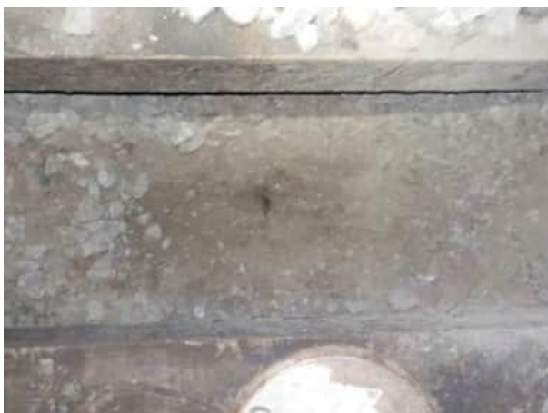
Bild 29: Gleis 21-425, km 24.030: Blick auf die Planie
