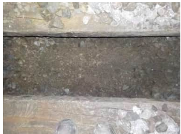
Bild 40: W9, km 24.815, Hauptstrang: Blick auf die Planie
