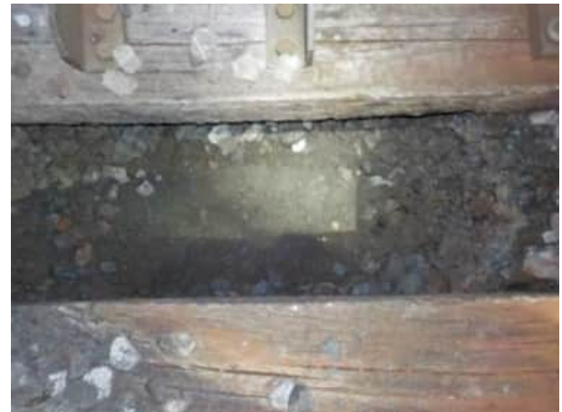
Bild 32: W6, km 24.706 : Blick auf die Planie
