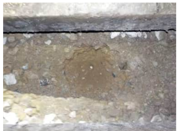
Bild 66: Gleis 92, km 25.060 : Blick in den Aufschluss, der Unterbau besteht aus leicht siltigem Kies mit Sand und Schotter (Bodengruppe GP-GM)
