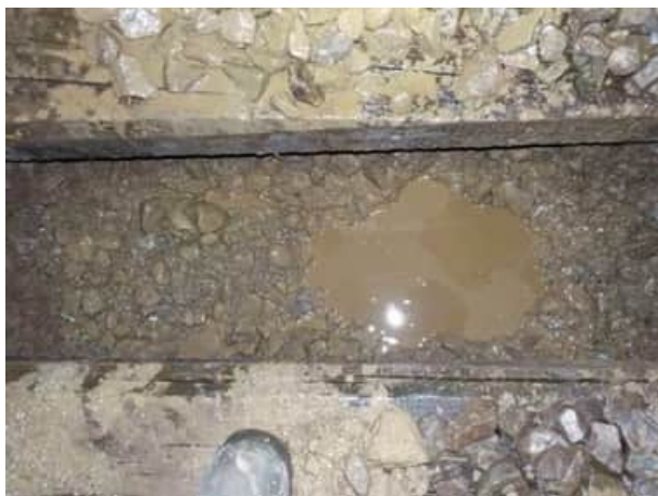
Bild 87: Gleis 425, km 25.770: Blick in den Aufschluss, der Unterbau besteht aus Kies mit wenig Sand (Bodengruppe GW)
