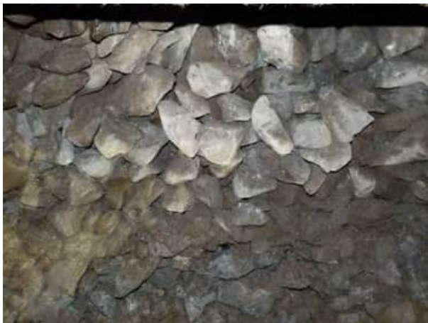
Bild 27: Gleis 21-425, km 23.920: Schotter in Gleismitte bis 45 cm unter SwOK allenfalls gering bis mittelmäßig (S1-S2) verschmutzt, gut stopf- und reinigbar
