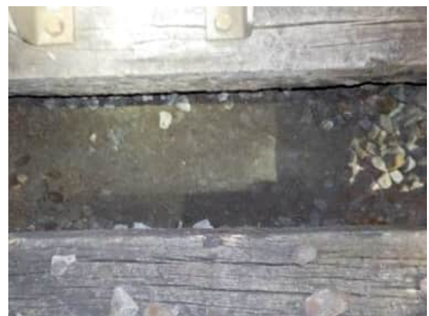
Bild 36: W7, km 24.767 : Blick auf die Planie
