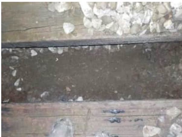
Bild 53: Gleis 92, km 24.970 : Blick auf die Planie
