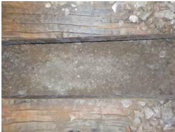
Bild 67: Gleis 91, km 25.170: Blick auf die Planie
