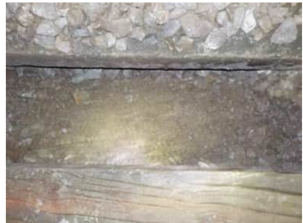
Bild 100: Gleis 325, km 25.890: Blick auf die Planie
