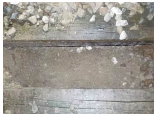
Bild 64: Gleis 92, km 25.060 : Blick auf die Planie
