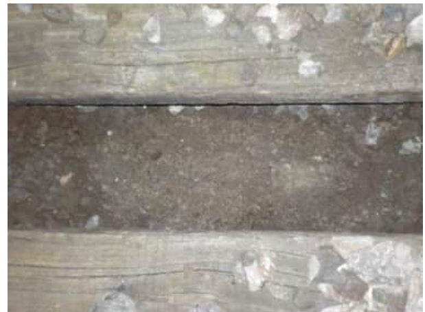
Bild 58: Gleis 91, km 24.970: Blick auf die Planie
