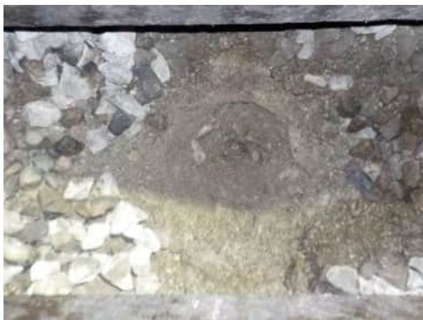
Bild 63: Gleis 91, km 25.055 : Blick in den Aufschluss, der Unterbau besteht aus leicht siltigem Kies mit Sand und einzelnen Steinen (Bodengruppe GW-GM)
