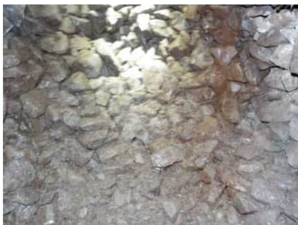
Bild 83: Gleis 92, km 25.400: Schotter in den Schienenbereichen allenfalls mittelmäßig (S2) verschmutzt, wirksam stopf- und reinigbar
