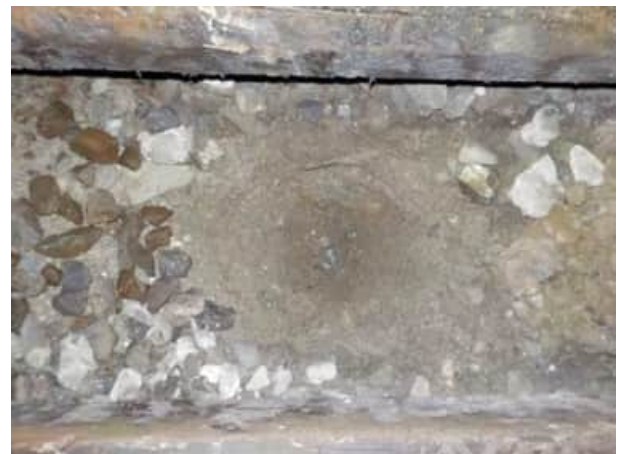
Bild 72: Gleis 92, km 25.170: Blick in den Aufschluss, der Unterbau besteht aus sauberem Kies mit Sand und einzelnen Schotter/Steinen (Bodengruppe GW)
