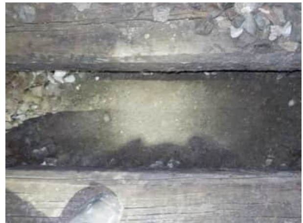
Bild 46: Gleis 92, km 24.850: Blick auf die Planie
