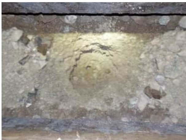
Bild 69: Gleis 91, km 25.170: Blick in den Aufschluss, der Unterbau besteht aus leicht siltigem Kies mit Sand und einzelnen Steinen (Bodengruppe GP-GM)
