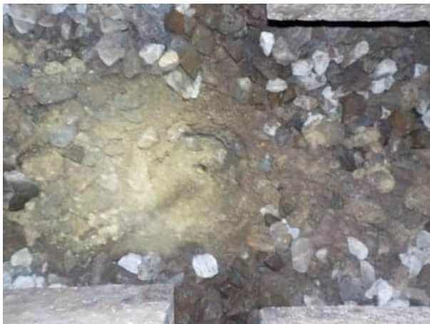
Bild 45: W8/9, km 24.815, Ablenkung: Blick in den Aufschluss, der Unterbau besteht aus leicht siltigem Kies mit Sand (Bodengruppe GW-GM)
