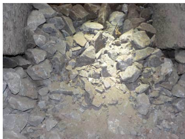
Bild 30: Gleis 21-425, km 24.030: Schotter in den Schienenbereichen gering bis mittelmäßig (S1-S2) verschmutzt, gut stopf- und reinigbar
