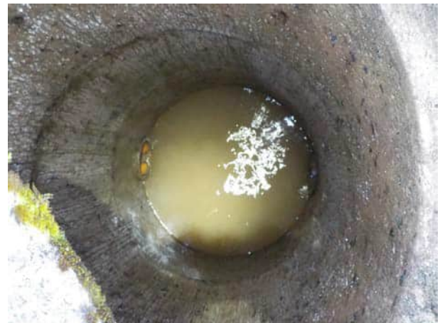
Bild 52: Blick in den Entwässerungsschacht bei ca. km 24.910; ausreichende Tiefenlage der Leitungen
