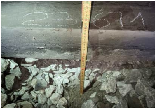
Litti, Gleis 11 Km. 23.671 Lage, im Tunnel Schwellen, Holz Befestigung, Ke Schotter 38 cm ab Schwellenoberkannte Schotter-Sandgemisch ab 38 cm
