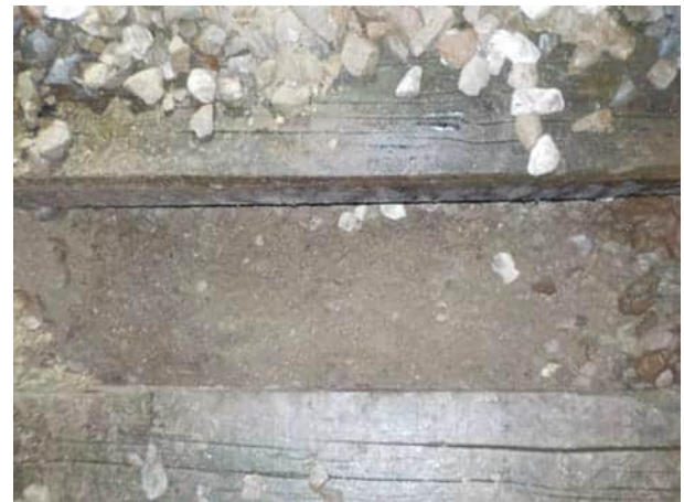
Bild 64: Gleis 92, km 25.060 : Blick auf die Planie
