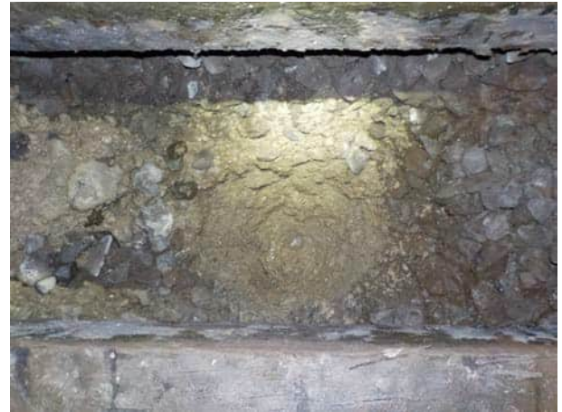
Bild 92: Gleis 425, km 25.830: Blick in den Aufschluss, der Unterbau besteht aus leicht siltigem Kies mit (wenig) Sand und einzelnen Steinen (Bodengruppe GW-GM)
