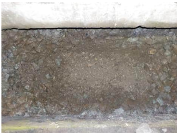
Bild 23: Gleis 21-425, km 23.815: Blick auf die Planie
