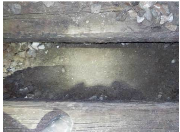
Bild 46: Gleis 92, km 24.850: Blick auf die Planie
