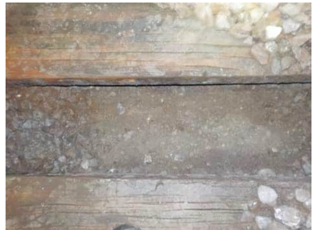
Bild 76: Gleis 92, km 25.290: Blick auf die Planie
