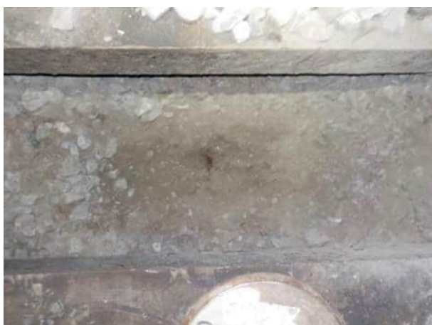
Bild 29: Gleis 21-425, km 24.030: Blick auf die Planie
