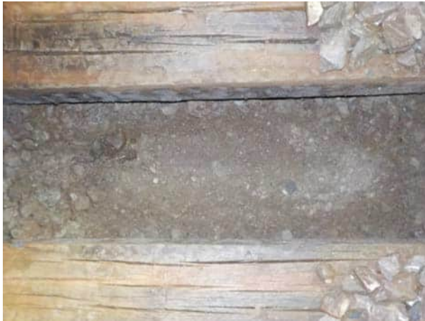
Bild 73: Gleis 91, km 25.300: Blick auf die Planie
