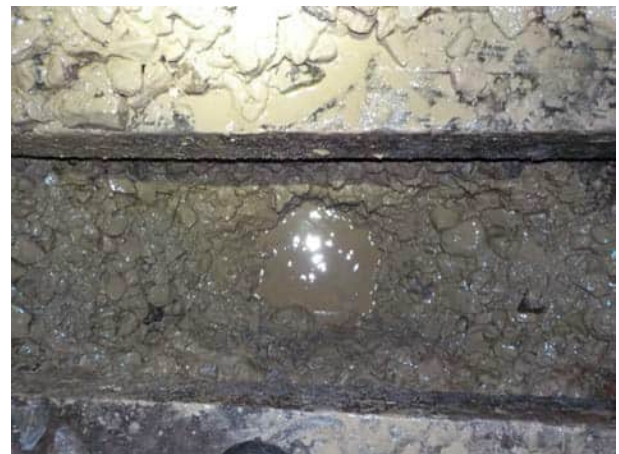
Bild 90: Gleis 325, km 25.770: Blick in den Aufschluss, der Unterbau besteht aus Kies mit wenig Sand und einzelnen Steinen (Bodengruppe GW)
