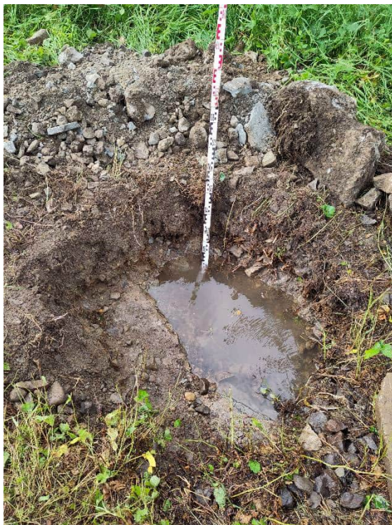
Vista della trincea 3 per la prova di infiltrazione, riempimento 0.3 m 3 di acqua
