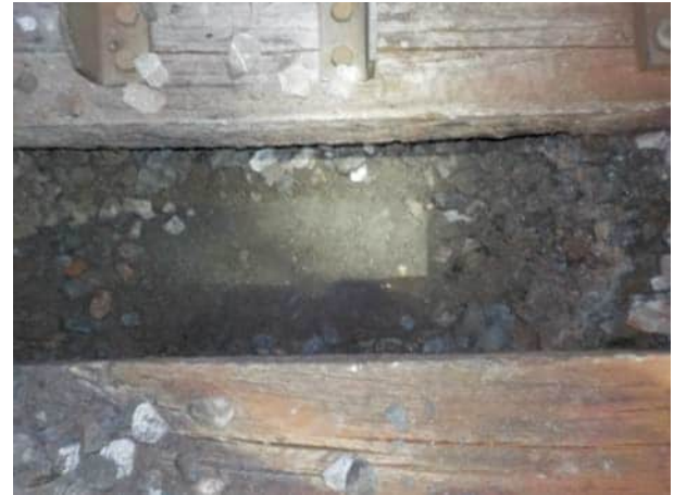
Bild 32: W6, km 24.706 : Blick auf die Planie
