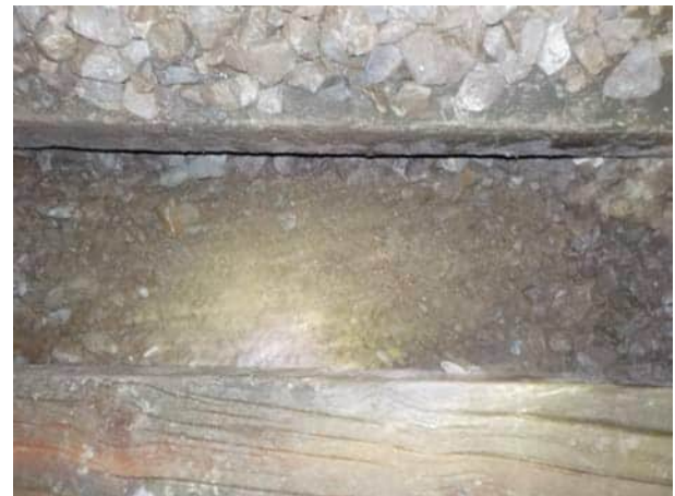
Bild 100: Gleis 325, km 25.890: Blick auf die Planie
