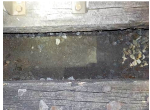
Bild 36: W7, km 24.767 : Blick auf die Planie
