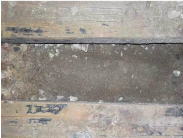
Bild 49: Gleis 92, km 24.900: Blick auf die Planie
