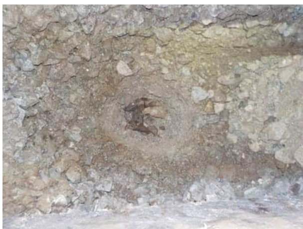
Bild 25: Gleis 21-425, km 23.815: Blick in den Aufschluss, der Unterbau besteht aus sauberem Kies mit Sand (Bodengruppe GW)
