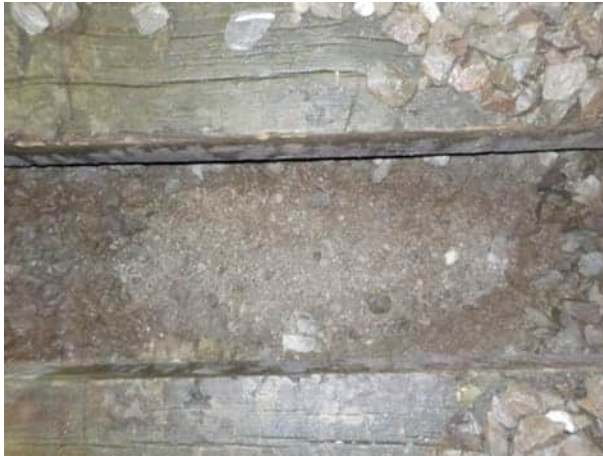
Bild 61: Gleis 91, km 25.055 : Blick auf die Planie
