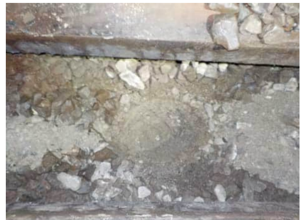
Bild 84: Gleis 92, km 25.400: Blick in den Aufschluss, der Unterbau besteht aus leicht siltigem Kies mit Sand und Steinen (Bodengruppe GP-GM)
