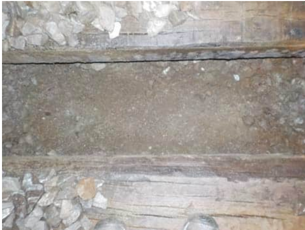
Bild 79: Gleis 91, km 25.400: Blick auf die Planie
