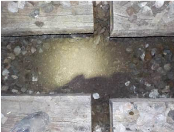
Bild 43: W8/9, km 24.815, Ablenkung: Blick auf die Planie
