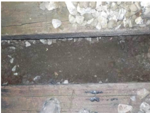
Bild 53: Gleis 92, km 24.970: Blick auf die Planie
