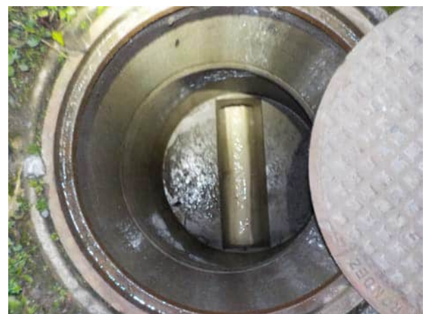
Bild 12: Blick in den Entwässerungsschacht bei ca. km 23.690; prinzipiell ausreichende Tiefenlage der Leitungen, Gleisbereich aber vermutlich nicht angeschlossen
