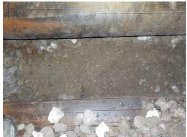
Bild 70: Gleis 92, km 25.170: Blick auf die Planie
