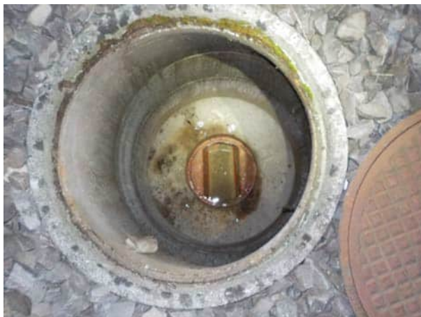
Bild 35: Blick in den Entwässerungsschacht bei ca. km 24.744; ausreichende Tiefenlage der Leitungen
