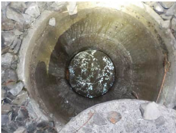
Bild 39: Blick in den Entwässerungsschacht bei ca. km 24.810; ausreichende Tiefenlage der Leitungen
