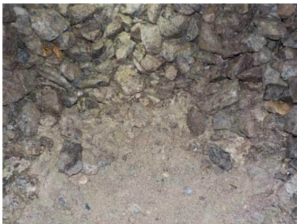
Bild 13: W 1, km 23.725 (Bereich seitliche Schiebung): am Schwellenkopf sind lediglich im Bereich der letzten 5 cm geringe Verlehmungen (S4) vorhanden
