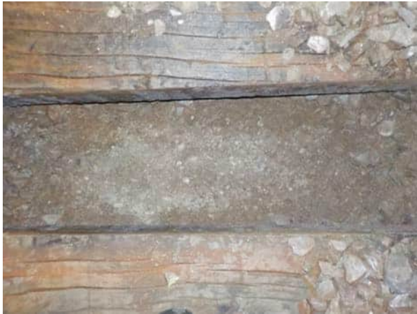
Bild 67: Gleis 91, km 25.170: Blick auf die Planie
