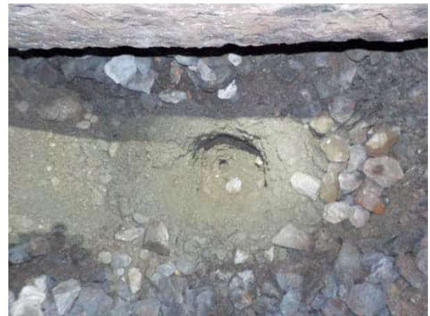
Bild 34: W6, km 24.706 : Blick in den Aufschluss, der Unterbau besteht aus (leicht) siltigem Kies mit viel Sand (Bodengruppe GM)
