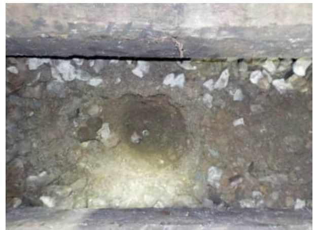
Bild 48: Gleis 92, km 24.850: Blick in den Aufschluss, der Unterbau besteht aus leicht siltigem Kies mit Sand und einz. Schotter/Steinen (Bodengruppe GW-GM)
