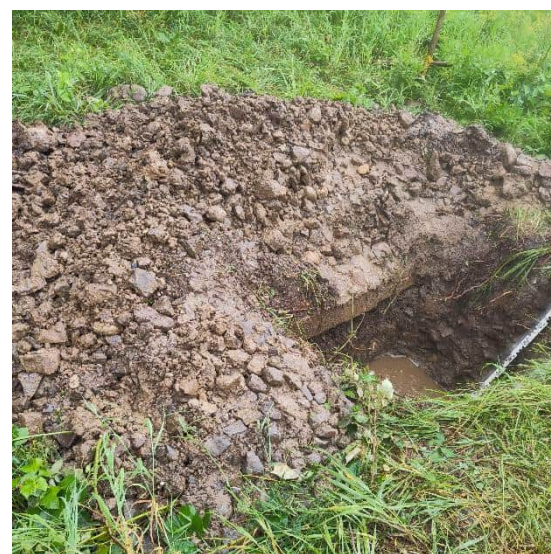
Tipologia di materiale trincea 2: GW-GM
