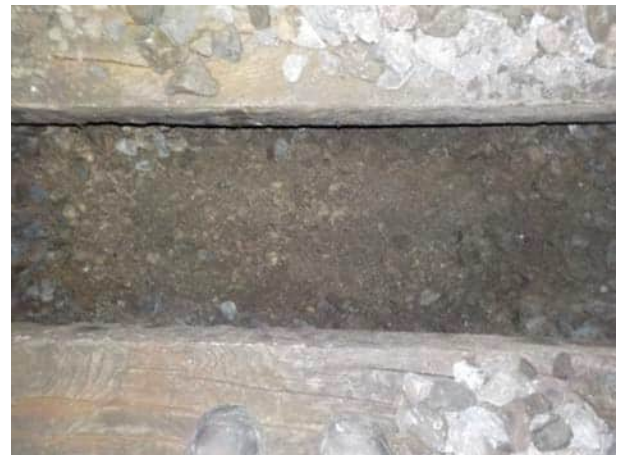
Bild 40: W9, km 24.815, Hauptstrang: Blick auf die Planie
