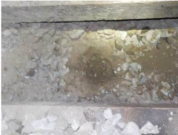
Bild 31: Gleis 21-425, km 24.030 : Blick in den Aufschluss, der Unterbau besteht aus leicht siltigem Kies/Schotter mit Sand (Bodengruppe GP-GM)
