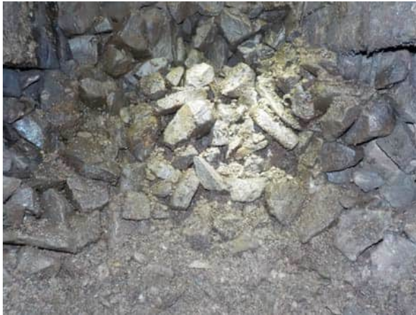
Bild 97: Gleis 425 km 25.890: Schotter in den Schienenbereichen gering bis mittelmäßig (S1-S2) verschmutzt, wirksam stopf- und reinigbar
