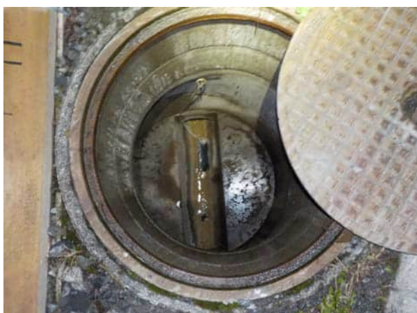
Bild 17: Blick in den Entwässerungsschacht bei ca. km 23.727; prinzipiell ausreichende Tiefenlage der Leitungen, Gleisbereich aber vermutlich nicht angeschlossen
