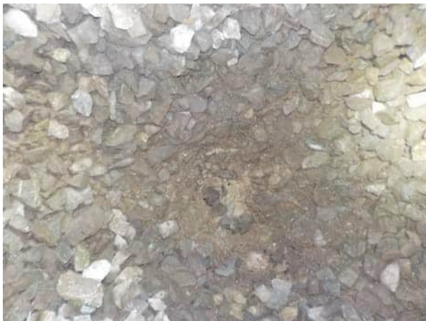
Bild 57: Gleis 92, km 24.970: Blick in den Aufschluss im Bereich der zukünftigen Diagonalen (neue Weiche 8); der Unterbau besteht aus leicht siltigem Kies mit Sand und ..Schotter/Steinen (Bodengruppe GP-GM)
