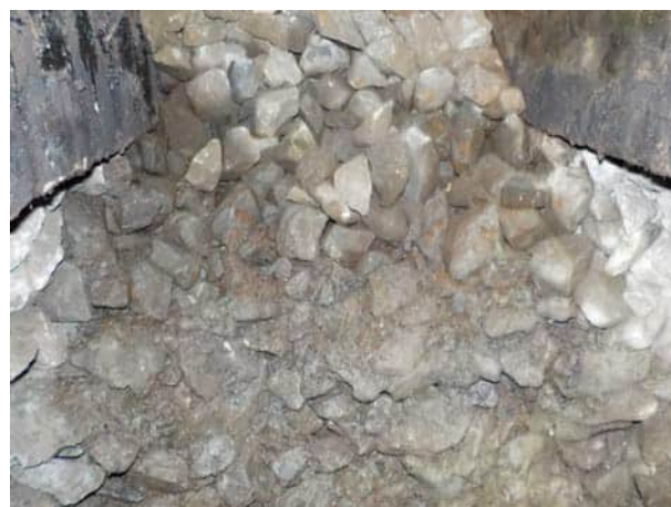
Bild 26: Gleis 21-425, km 23.920: Schotter in den Schienenbereichen mittelmäßig verschmutzt (S2), wirksam stopf- und reinigbar
