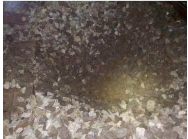
Bild 56: Gleis 92, km 24.970: Blick auf den Aufschluss im Bereich der zukünftigen Diagonalen (neue Weiche 8)
