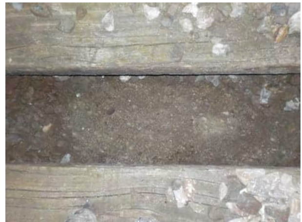
Bild 58: Gleis 91, km 24.970: Blick auf die Planie
