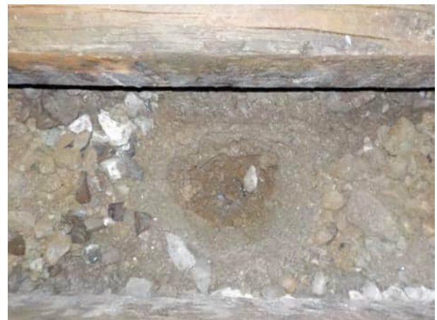
Bild 78: Gleis 92, km 25.290: Blick in den Aufschluss, der Unterbau besteht aus leicht siltigem Kies mit Sand und Steinen (Bodengruppe GP-GM)
