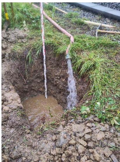
Vista della trincea 2 per la prova di infiltrazione, riempimento 0.4 m 3 di acqua
