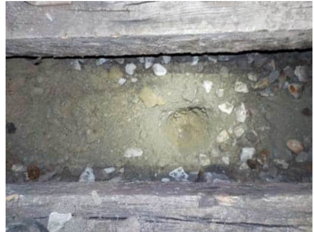
Bild 38: W7, km 24.767: Blick in den Aufschluss, der Unterbau besteht aus (leicht) siltigem Kies mit viel Sand (Bodengruppe GM)
