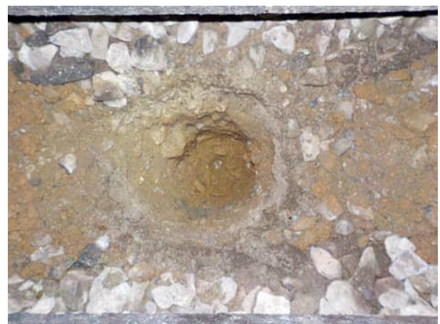
Bild 60: Gleis 91, km 24.970: Blick in den Aufschluss, der Unterbau besteht aus leicht siltigem Kies mit Sand (Bodengruppe GW-GM)
